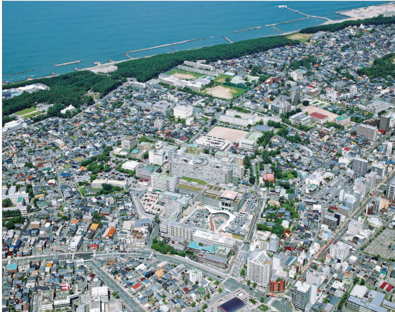
新潟大学旭町キャンパス 中央の高い建物が医歯学総合病院の病棟、その奥が医学科。 手前のヘリポートのある建物が外来診療棟。
